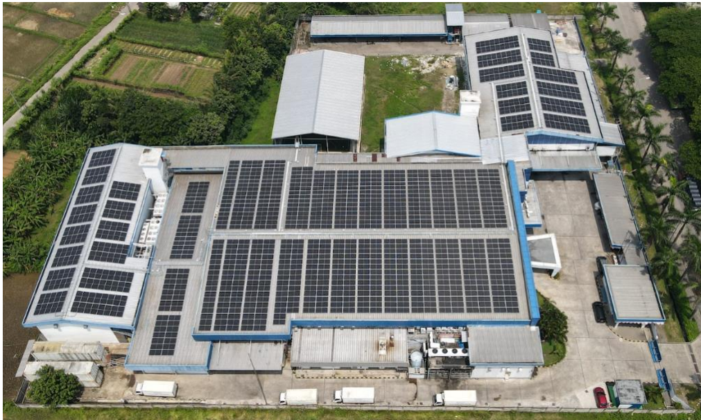
KFS の屋根に設置した 637 kWp 太陽光パネル
